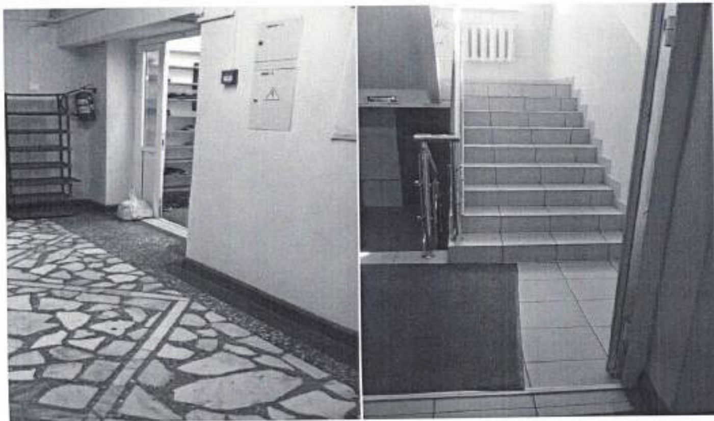
Фото № 4 Путь движение внутри здания, в т.ч. пути эвакуации
