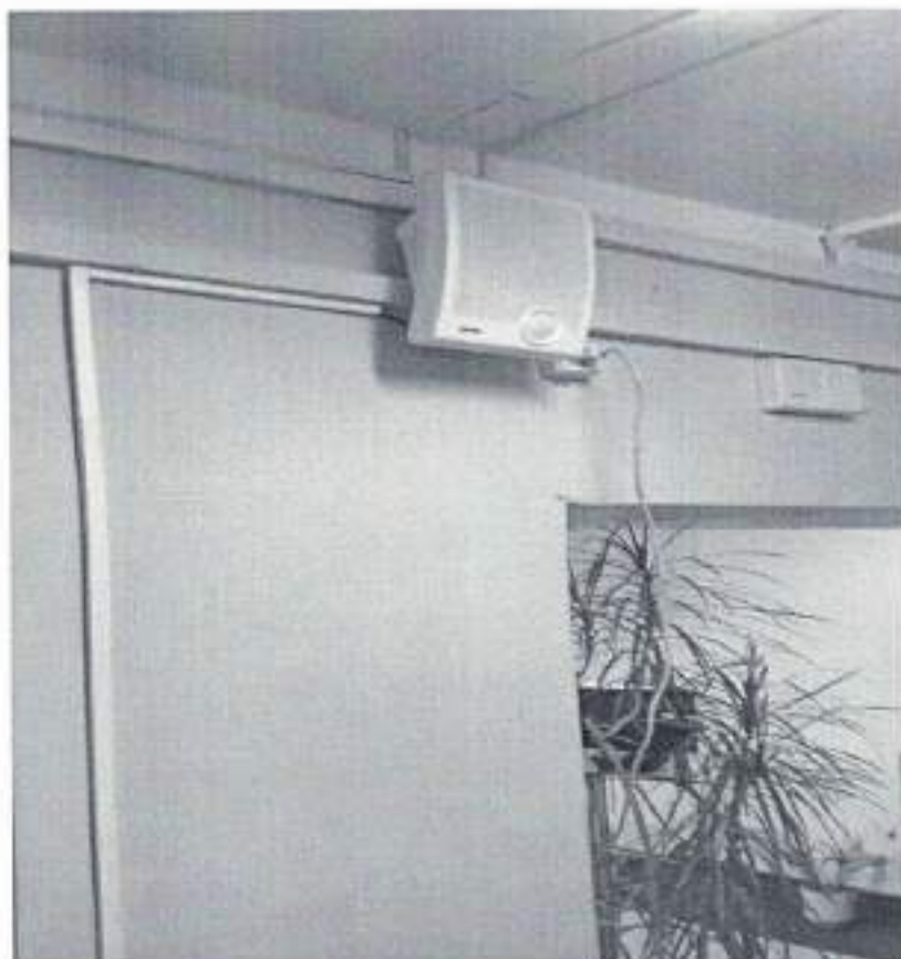
Фото : 10 Система информации и связи (оповещатель пожарной сигнализации)
