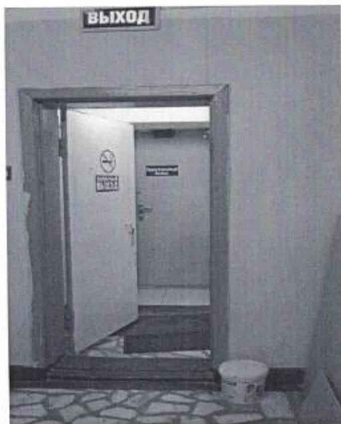
Фото №5 (эвакуационный выход)
